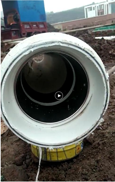
□ 固定衬套大口径双热熔管 件与管轴心不统一时的事故
